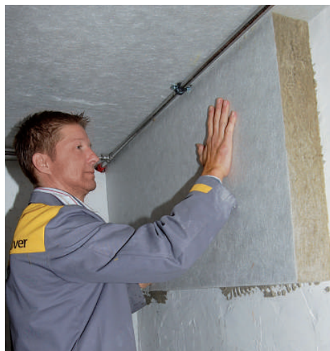
Empfehlung: Flankendämmung der Kellerwände mindestens in Plattenbreite (hier Topdec DP 3)
