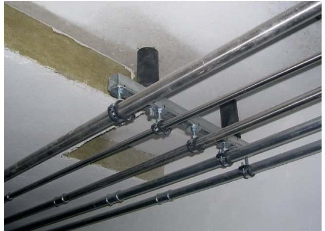
Decke: Topdec Universal, geklebt + gedübelt, gespachtelt
