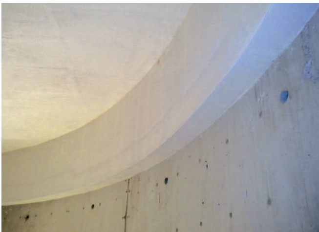
Decke + Flanke: Topdec Universal, geklebt + gedübelt, gespachtelt
