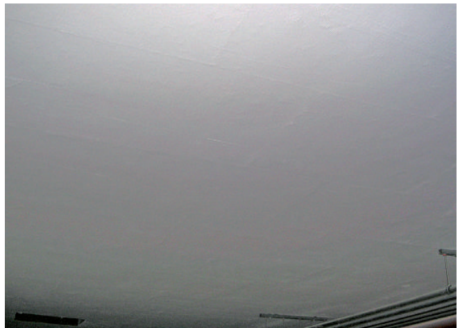
Decke: Topdec Universal, geklebt + gedübelt, gespachtelt
